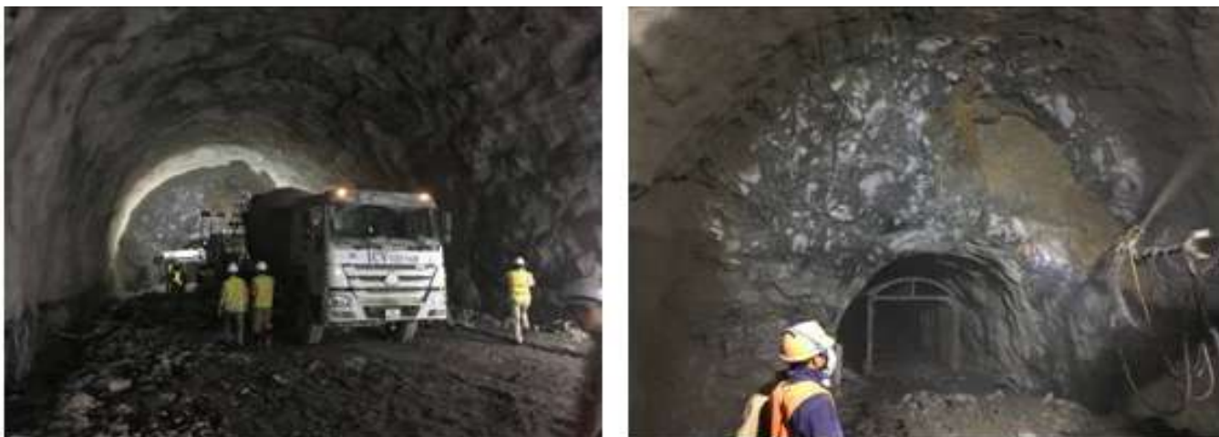
Рисунок 13. Буровзрывные работы при расширении вспомогательного тоннеля. Figure 13. Blasting workings during the expansion of the auxiliary tunnel.
