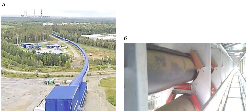
Рисунок 1. ТЛК золы Рефтинской ГРЭС. а – общий вид трассы 4390 м; б – грузовая и порожняя ветви свернутой в трубу ленты с цилиндрическими роликоопорами.
