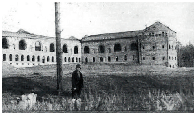
Здание Горного, которое так и не было достроено (снимок 20-х годов).
