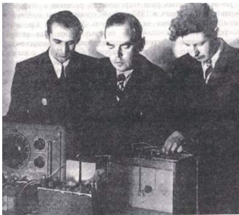
Первые испытания электролитического способа измерения удельного сопротивления образцов (1955 г.). Слева направо: А. А. Редозубов, Г. П. Саковцев, Л. С. Тальвинский.
